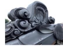
今年の1月から進めているお寺の寺務所棟の再生増築プロジェクトです。減築、改修、増築と全ての工事工程を抱えながら、ようやく完成形の全貌が明らかになりました。先日、既存棟の屋根から一度降ろした瓦をもう一度屋根に戻す作業が終了しました。新しい屋根ですが、古瓦に戻るだけで以前の雰囲気グッと戻った気がします。
