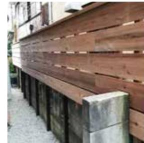
10年前に工事のお手伝いをさせていただいた住宅の修繕工事をさせていただきました。主に外部の塗装工事と外壁のメンテナンス工事です。経年変化で外部が痛む大きな原因は紫外線と水です。この避けられない二つの劣化要素とどのように付き合うかがポイントですが、一番は軒や庇などの屋根の存在が大きいと感じます。人が夏には帽子をかぶり、日傘をさして外に出る感覚と似ています。直接当たらないのが一番ですが、当たりにくくする事が大切です。また、劣化に強い素材を選ぶ事も大切です。この建物では、外壁の一部に漆喰が採用されています。塗装面や木部に比べると汚れはあるものの、劣化が少ない事が分かりました。建設当初に選ぶ仕上げ材は後々のメンテナンス費用にも関わる重要なポイントになります。
