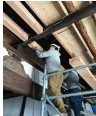
補強材 取り付け中
