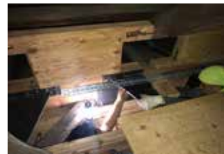
ブレース材 取り付け中
