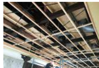
ブレース材 取り付け完了
