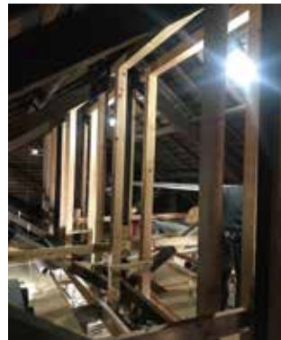
補強材 取り付け完了
